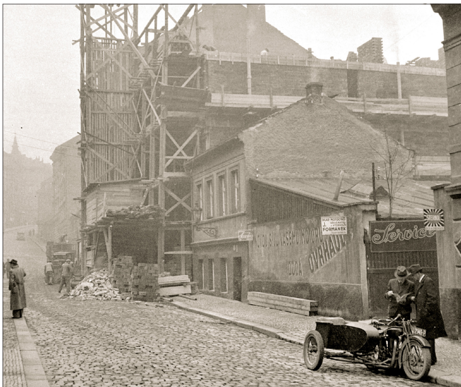
Horymírova 72, dnes Košícká. V těchto kůlnách a domečku typickém pro starou vršovickou zástavbu sídlila firma Formánek, generální zástupce Saroléa a Velocette pro ČSR. Také zde bylo „informační centrum“ klubu. Ačkoliv tehdejší dobu ovšem nelze srovnávat s dneškem, stejně by člověk očekával reprezentativnější prostory
